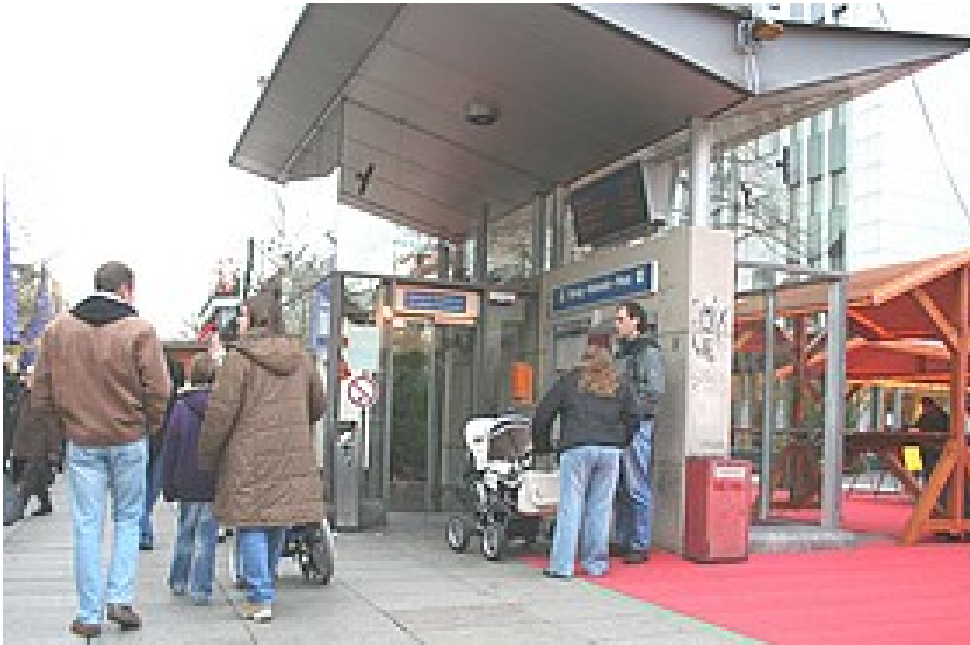
Aufzug zur U-Bahn in Duisburg. Foto: djan
